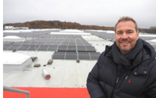
Klinkerfassade, Ladesäulen, ein Wabenregal für Sechs-Meter-Rohrlängen und Photovoltaik auf dem Dach – Markus Meyer vom Bauherrn Goodman, Mieter Paulsen und die Gemeinde Seevetal haben ganze Arbeit geleistet.
